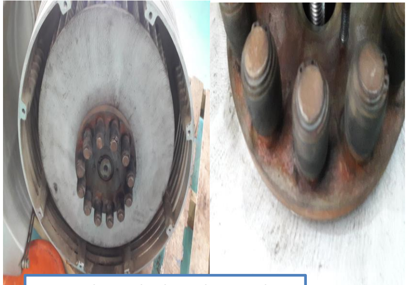
Gomas de acoplamiento desgastadas
